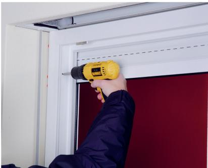
**7** Kontrolle das Kasten press auf Rahmen sitzt / Fenster ausrichten (Oberkante Rahmen = Unterkante Kasten) und Fenster gemäß Richtlinien versetzen.
