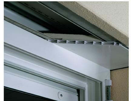
**9** Deckel montieren und verschrauben.
