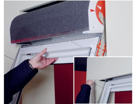
**6** Element in Kasten einbauen. Dabei Kasten auf Fenster drehen, einschieben u. Fenster darunter winklig drehen. Bei Verwendung der Montagestifte diese ziehen.
