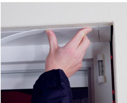
**10** Klipsleiste montieren
