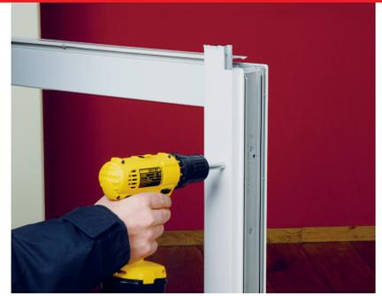
**3** Führungsschienen montieren. Schienen sind je Seite 7mm einzurücken.
