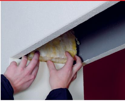
**1** Vorhandene Auflagerbereiche bauseits dämmen. Dämmung nicht im Lieferumfang enthalten.
