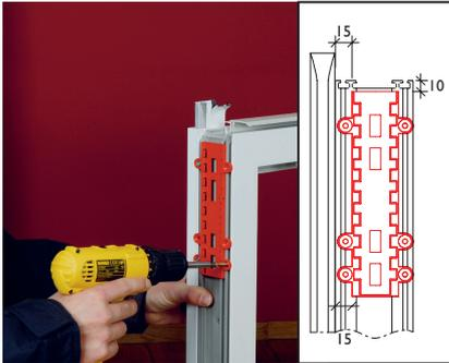
**4** Montageschuhe montieren, Aussenkante Schuh 15mm von Aussenkante Rahmen. Bei großen Elementen mitgelieferte Montagestifte einstecken.
